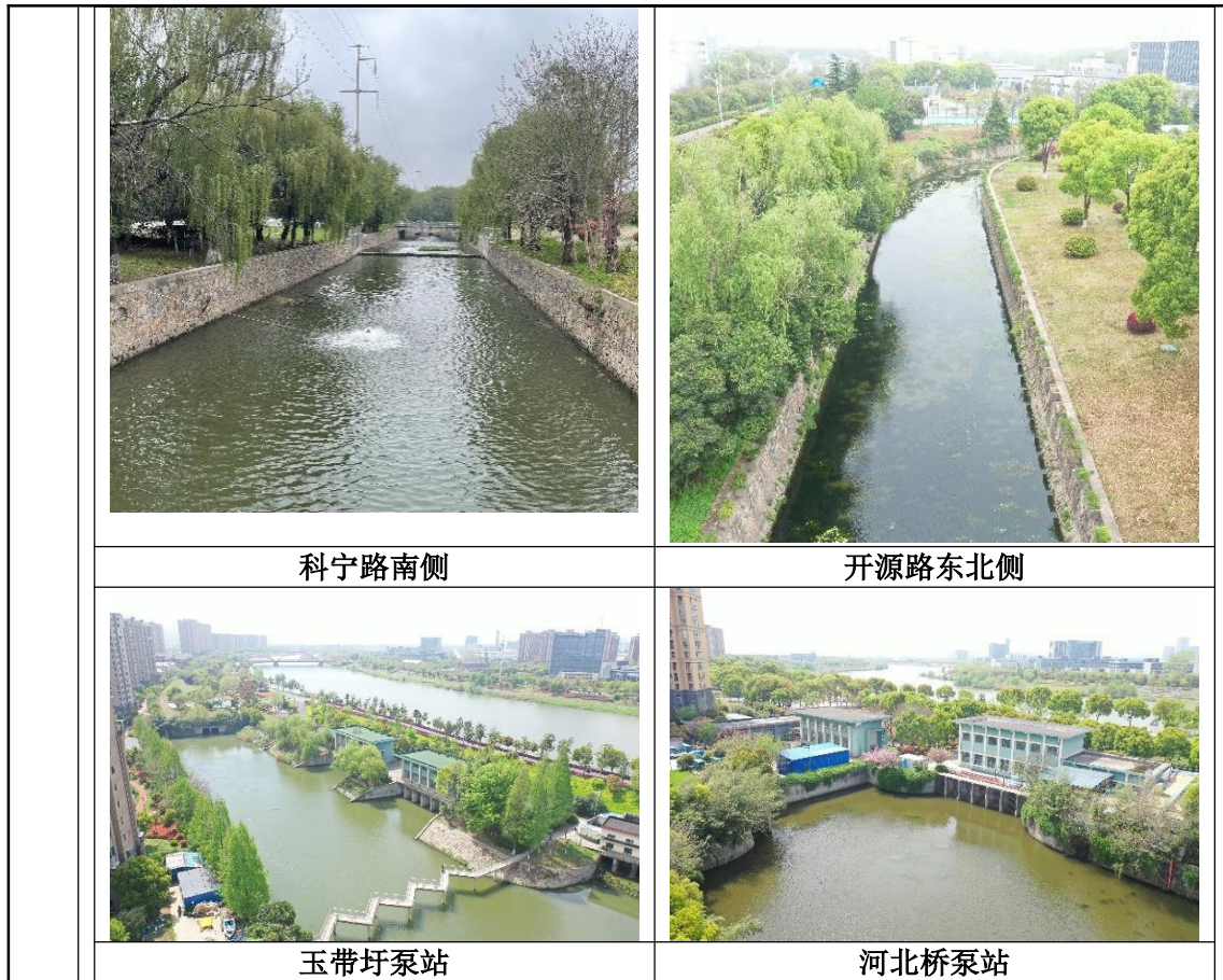
图 3-1 玉带圩河（高新园段）河道施工后实景
