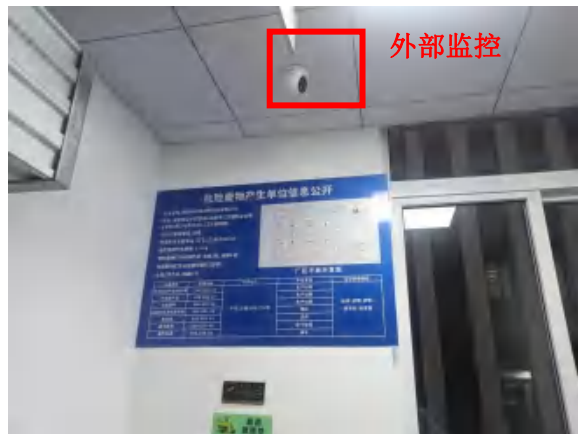
危废间单位信息公开及外部摄像头
